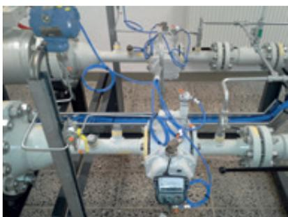
Abb. 1: Erdgas-Druckregelstrecke Klanxbüll (oben) und neu eingebaute eichfähige Erdgaszähler (unten)
