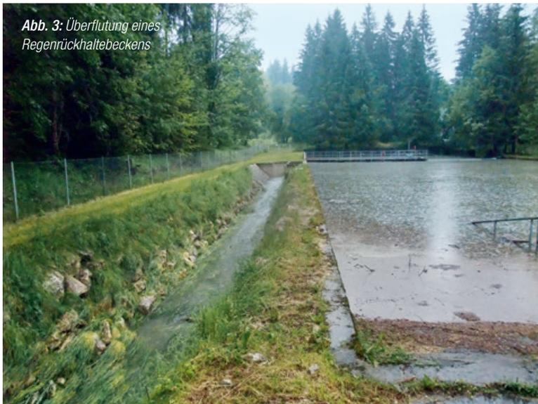
Abb. 3: Überflutung eines Regenrückhaltebeckens
