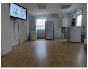
**Abbildung 130:** KWK-Geräte (links), Wärmepumpen, Brennwertkessel und Brennstoffzelle (rechts)
