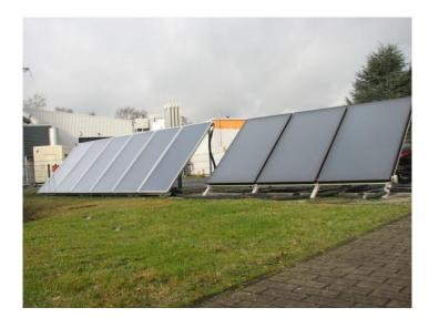
**Abbildung 128:** Solarthermiemodule für die Brennwert plus Solar- und Gaswärmepumpenanlage
