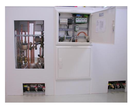
Abbildung 135: Installationswand mit Sichtöffnung und Schaltkasten
