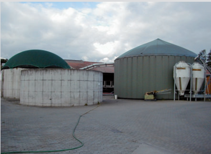
Biogasanlage mit Fermenter, Vorgrube für Gülle und Nachgärbehälter
