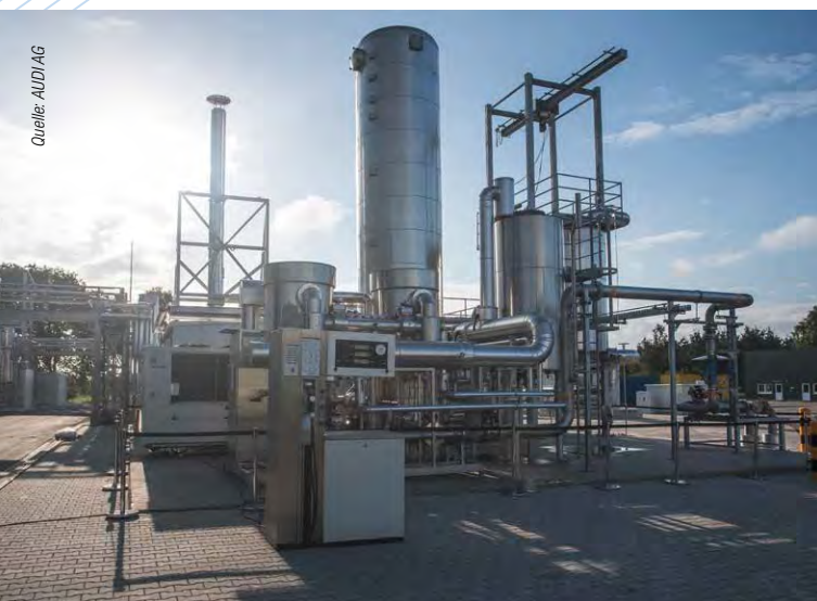
Die Audi-e-gas-Anlage im norddeutschen Werlte war die weltweit erste Anlage im industriellen Maßstab, die aus CO 2 und erneuerbarem Strom einspeisefähiges, synthetisches Erdgas generiert.
