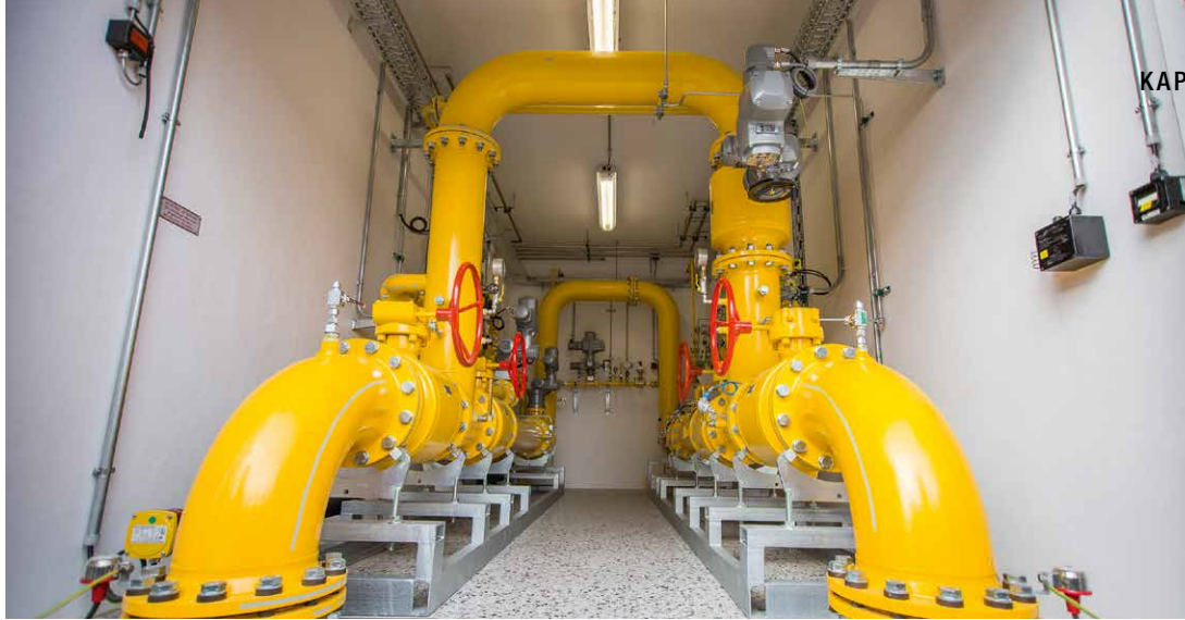
In der Gasdruckregel- und Messanlage wird dem Erdgas der produzierte Wasserstoff beigemischt.
