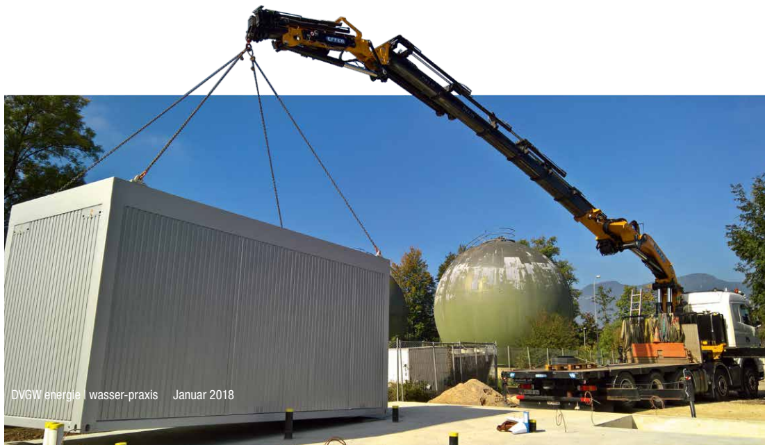
In dem Container werden die Biologie und die Nährstoffe für die biologische Methanisierung untergebracht.
