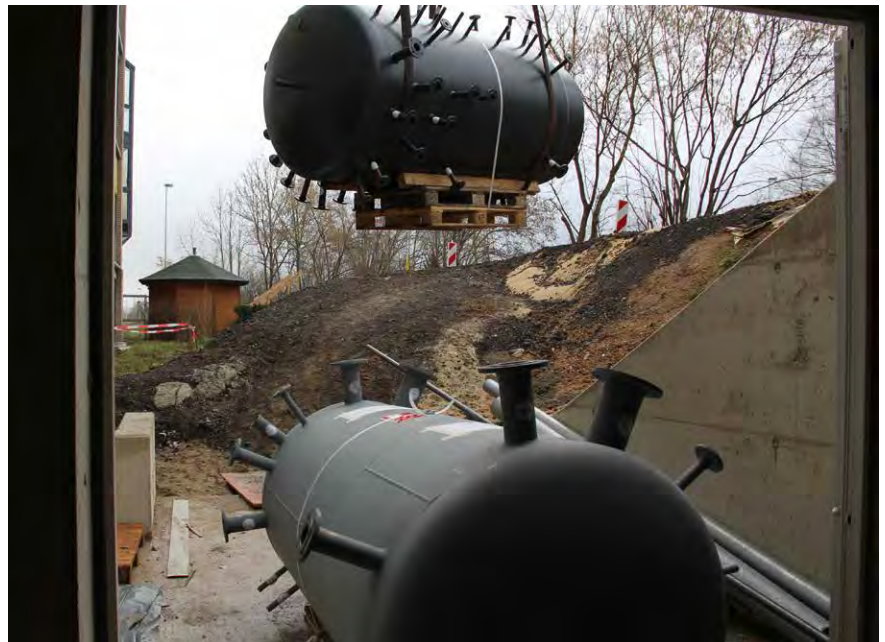
Anlieferung des Schichtenspeichers (im Hintergrund schwebend)
