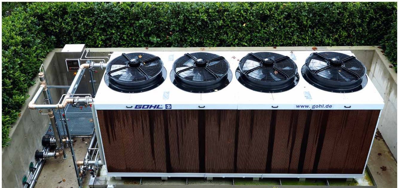
Zur weiteren Geräuschreduzierung ist der adiabatische Rückkühler mit einer Hecke umfasst.
