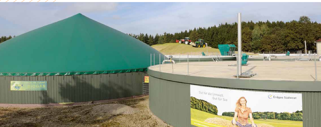
Aus Biogas wird Bio-LNG: Bei dem biohybrid-Konzept wird Biogas zunächst zu Biomethan aufbereitet. Das Biomethan wird dann durch Herunterkühlen auf minus 162 °C zu Bio-LNG (Bio-Liquidified Natural Gas). Dabei verringert sich das Volumen deutlich: Aus 600 Kubikmetern gasförmigem Biomethan entsteht ein Kubikmeter flüssiges Bio-LNG, das z. B. in mobilen Tanks gespeichert werden kann.
