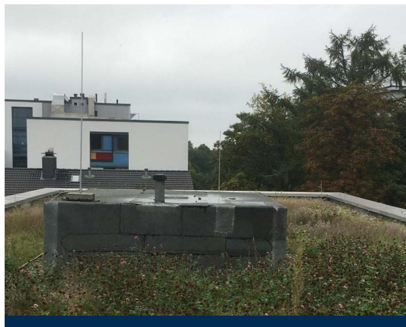
Ein solches Dach umzusetzen ist mit Schwierigkeiten verbunden. Erstmal muss bei der Bitumschicht mehr auf die lückendichte Verarbeitung geachtet werden als bei einem Dach ohne stehendes Wasser. Dazu muss eine Messung der abgeleiteten Wassermenge durchgeführt werden und Proben zur Bestimmung der Wasserqualität können entnommen werden. Desweiteren wurden Insektenfallen aufgestellt, um die Anzahl und Art der Insekten mit dem anderen Gründach zu vergleichen.
