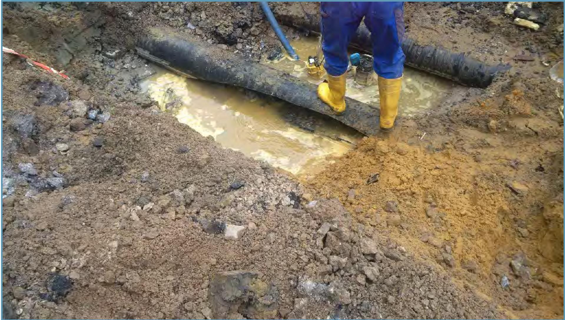
Beispiel Rohrschaden – Schalenbruch an Wasserleitung DN 300
