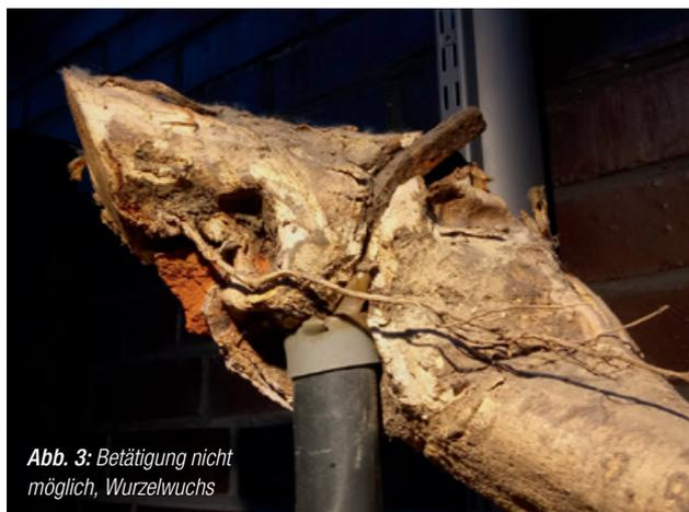
Abb. 3: Betätigung nicht möglich, Wurzelwuchs
